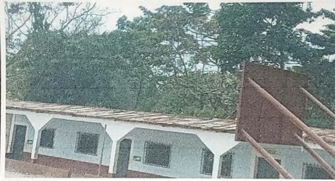
Foto1: Sustución de lámina por lámina troquelada.
